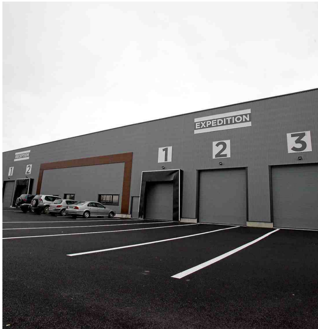
■ Les nouveaux quais pour les poids lourds construits cette année.
